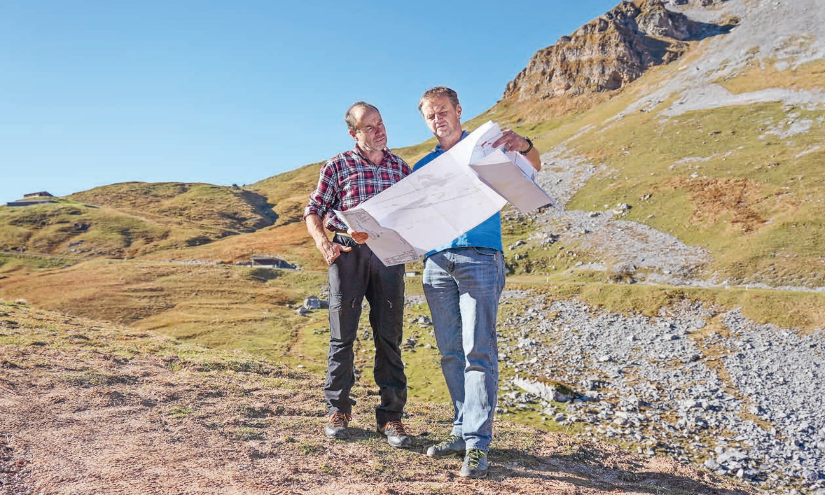
Anton Gisler (Engerer Rat und Allmendaufseher Kreis 4) und André Zwysig von der EWA-energieUri AG besprechen auf dem Klausen die frisch in den Boden verlegten Hochspannungsleitungen.
