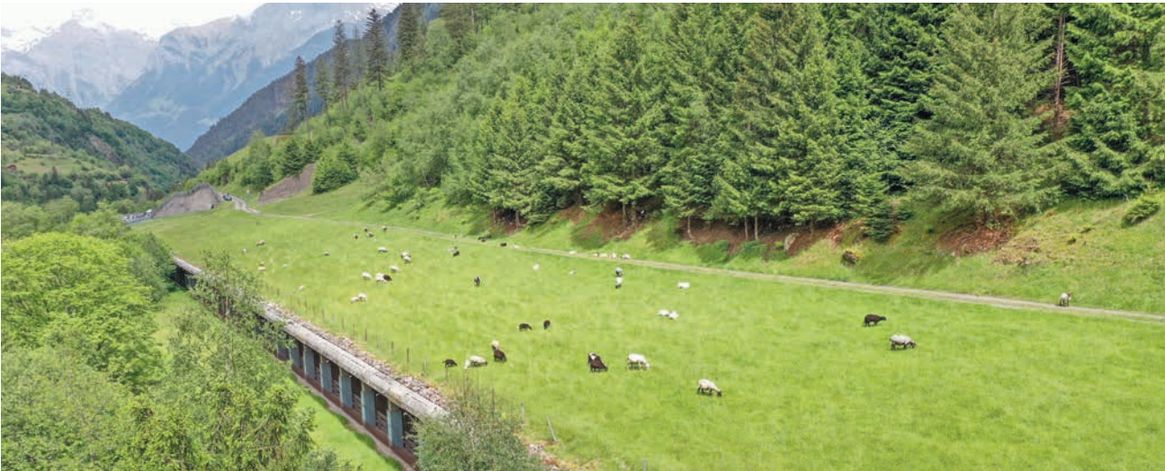
Mit dem Bundesamt für Strassen (ASTRA) schloss die Korporation Uri im vergangenen Geschäftsjahr eine Nutzungsvereinbarung für die Galeriedächer der Autobahn in den Gemeinden Gurtellen und Wassen ab.
